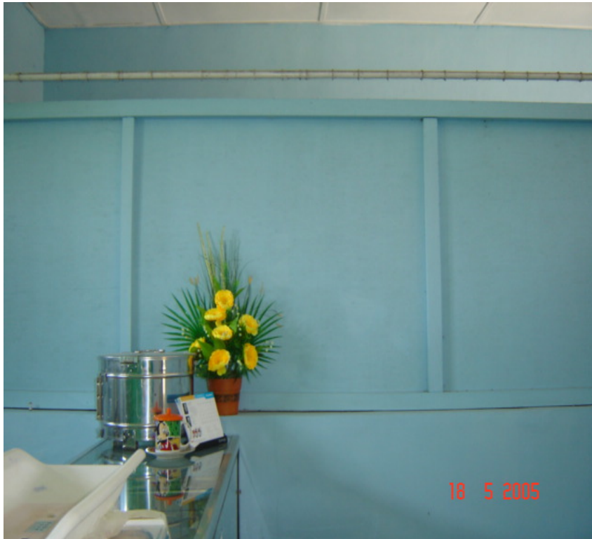
Kondisi dinding semi permanen di RS. X (tipe D)
