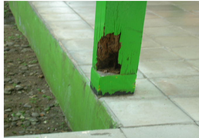
Kondisi tiang penyangga di RS. Y (tipe C)
