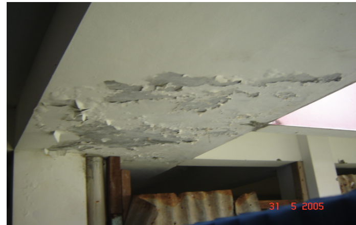
Kondisi dinding di RS. Z (tipe D)
