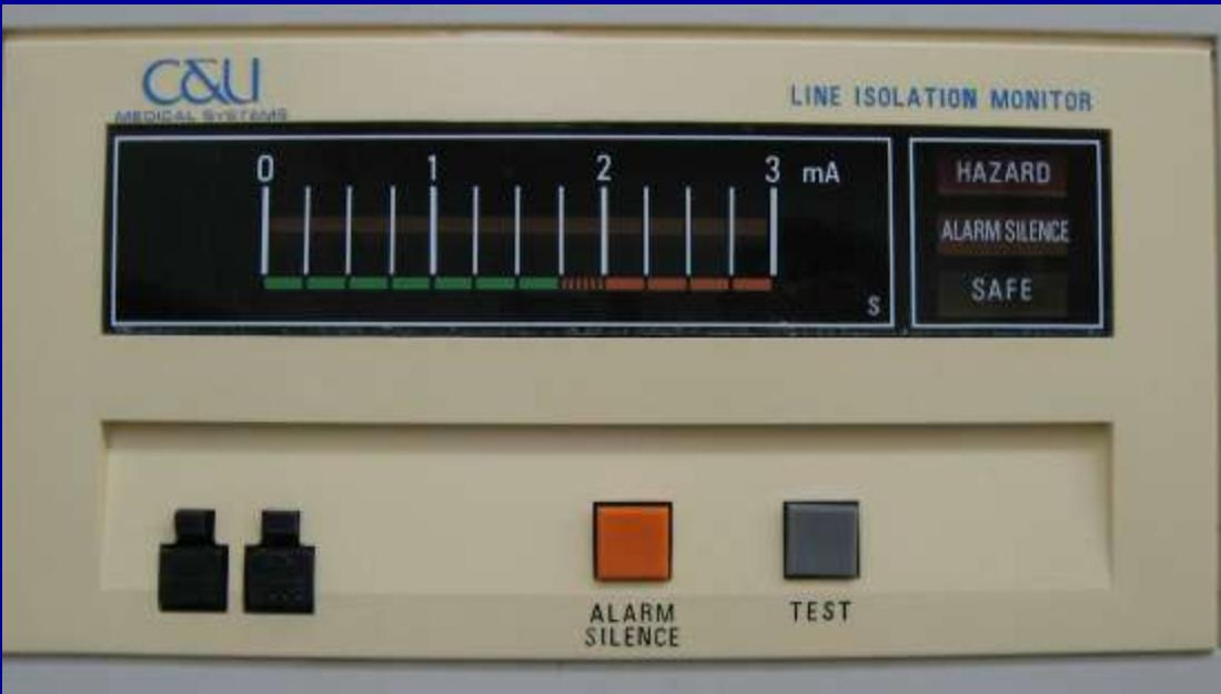
Grounding monitor dengan alarm yang akan berbunyi jika kawat grounding yang masuk ke dalam tanah putus
